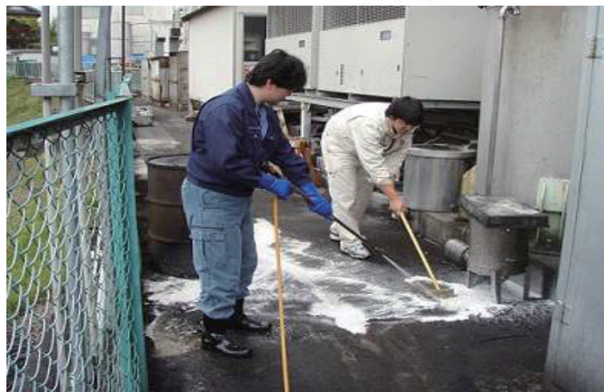
静岡県富士市・食品工場ボイラータンク周り洗浄
